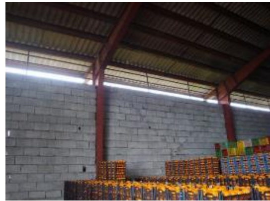
شکل ۳- اسکلت آهنی (سوله) انبار
