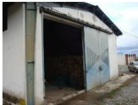
شکل ۲- درب‌های جانبی برای انبارهای با اندازه متوسط و بزرگ
