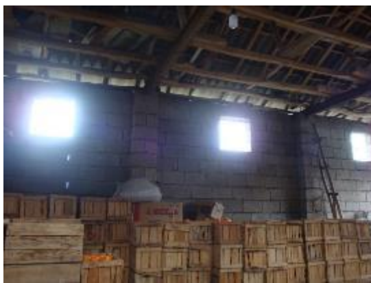
شکل ۱۱ - ایجاد روزنه بدون نصب پنجره
