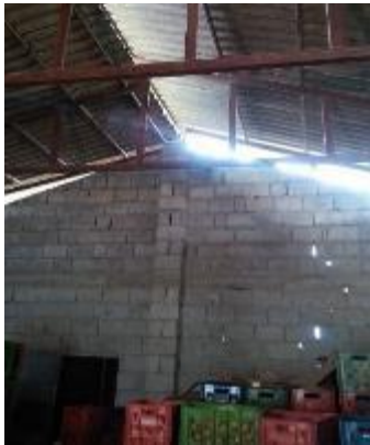
شکل ۴- اسکلت بلوکی انبار
