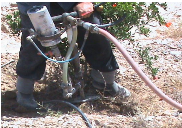
شکل ۱- تزریق پلی مر سوپر جاذب (هیدروژل) در
